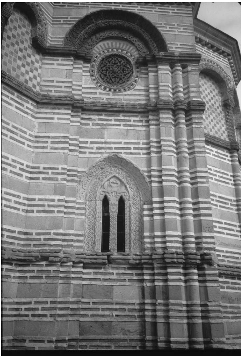
Сл. 10. Каленић, источни део јужне фасаде
