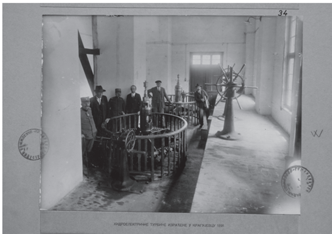
Индустријска хидроелектрична централа „Обилићево“, Крушевац у погону од 1891. године - турбине (изграђене у Крагујевцу)
