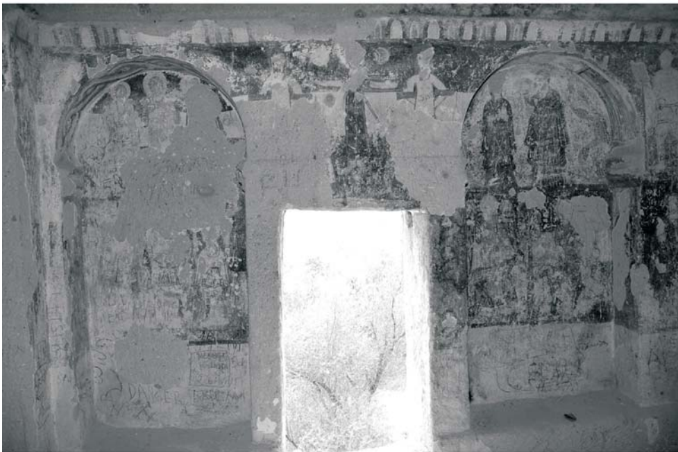
Fig. 6 — Vue générale du mur sud de la nef
