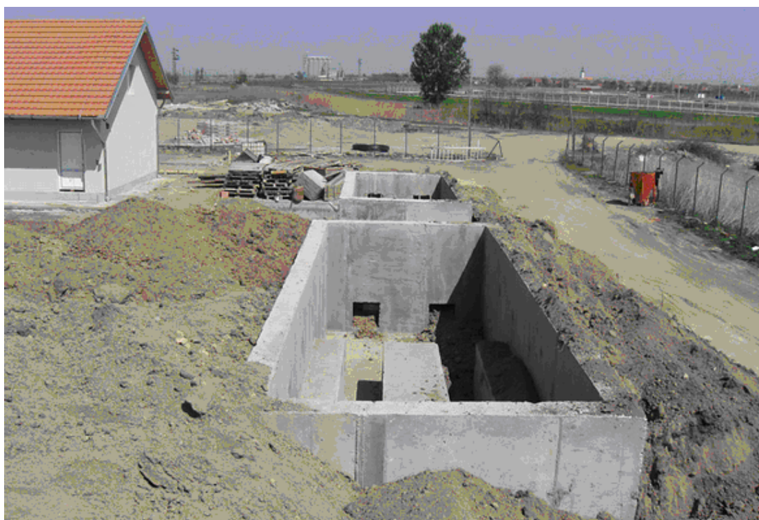
Слика 31. Постројење за пречишћавање отпадних вода (шахт са грубом решетком и песколов) Ковачица ( http://www.hiding.co.rs )
