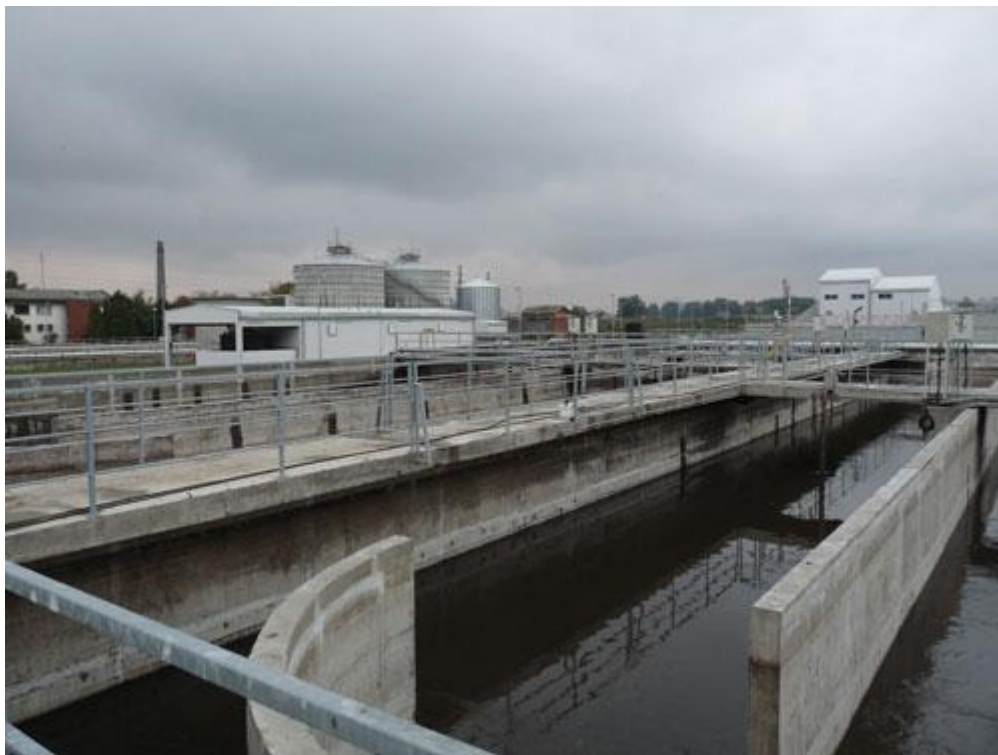
Слика 29. Постројење за пречишћавање отпадних вода Суботице ( http://www.buildmagazin.com )
