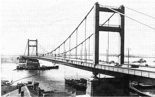
Сл. 7. Мост преко реке Саве у Београду – срушен у априлском рату 1941.
