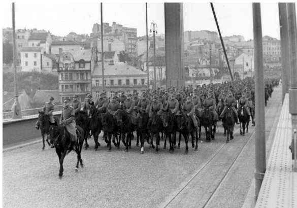
Сл. 8. Испитивање Моста краља Александра: коњица као пробно оптерећење
