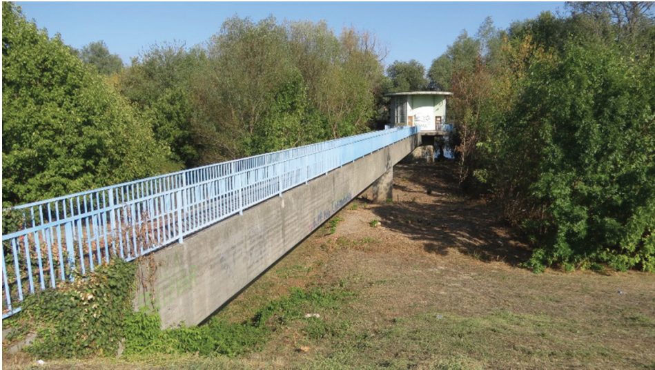
Слика 5. Рени бунар у алувијону Дунава на изворишту Штранд новосадског водовода (фото аутора)
