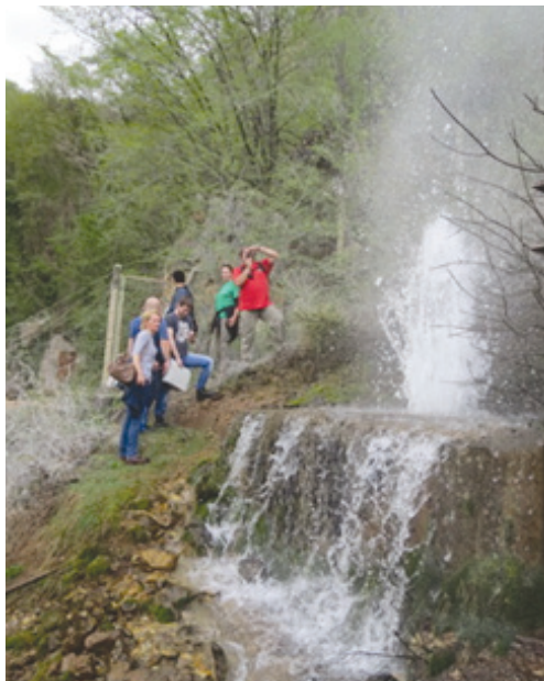
Слика 6. Каптажа врела Сељашнице захваћеног за водоснабдевање Пријепоља (фото аутора)
