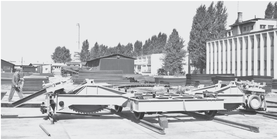
Пробна монтажа опреме за бродоградилште у Рангуну
