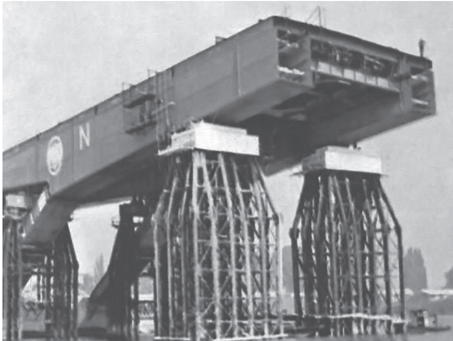
Монтажа моста Газела
