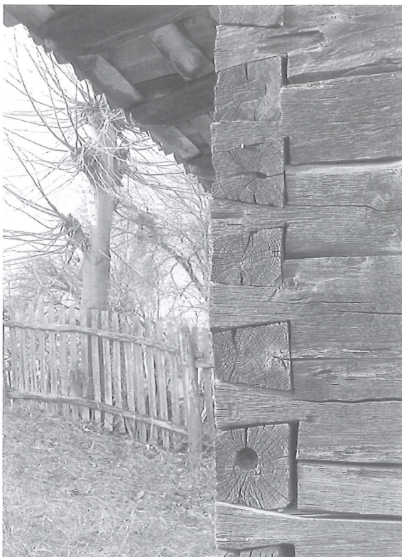
Casă de lemn din Tanda, detaliu. În imagine este ilustrat modul în care erau unite grinzile la casele de lemn. Foto Paun Es Durlić.
