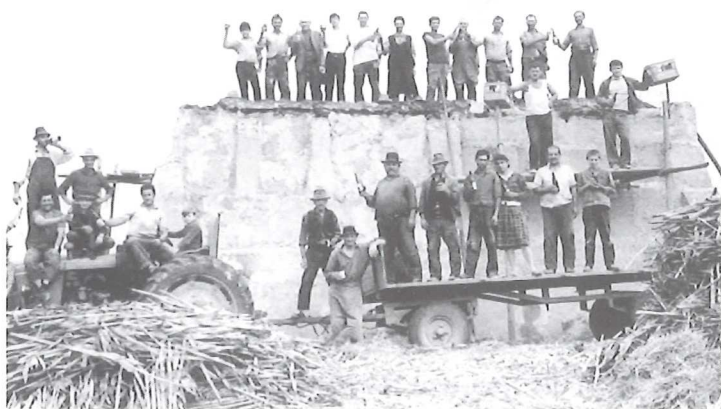
Cuptorul de cărămidă, sfârșitul anilor 1960. Sursa: colecție particulară.
