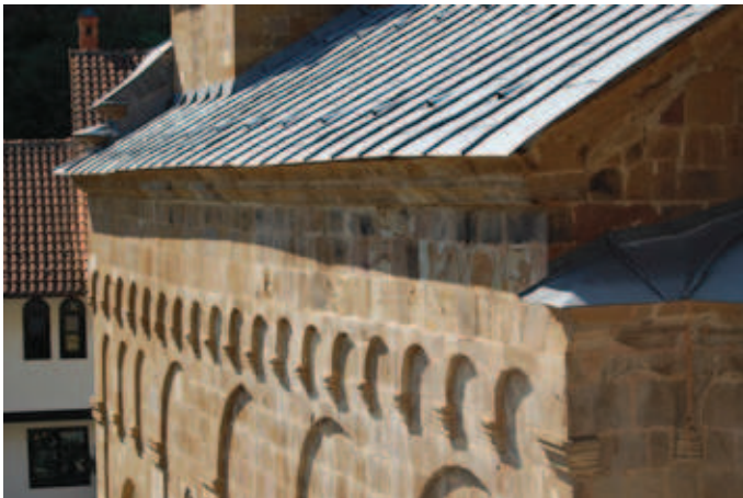
Сл. 7. Фриз слепих аркадица, јужна фасада (фотографија: Дубравка Прерадовић)
