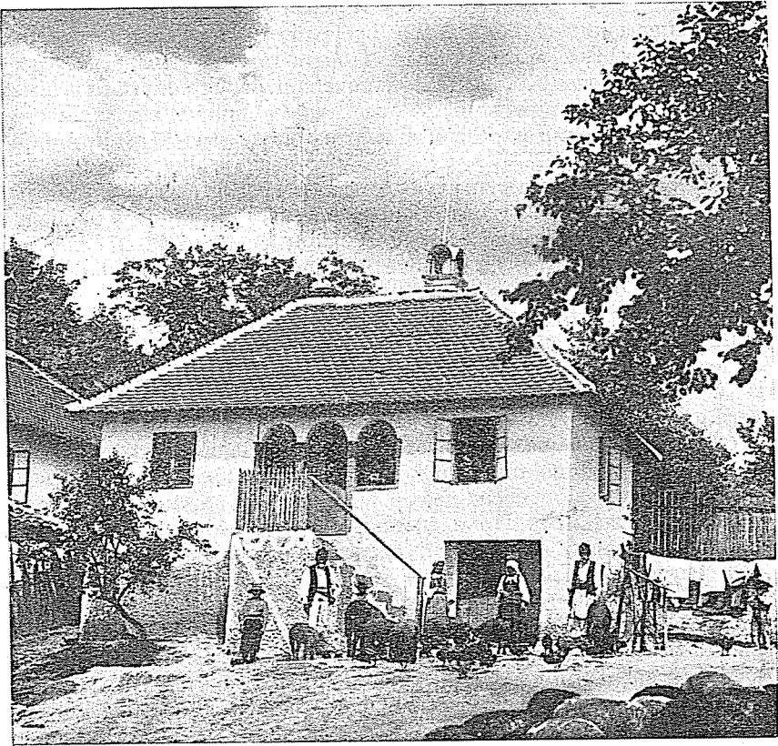
Сл. 1. — Моравска кућа са краја XIX века, развијене основе и са типичним лучним тремом (Из фототеке Етнографског музеја у Београду)
