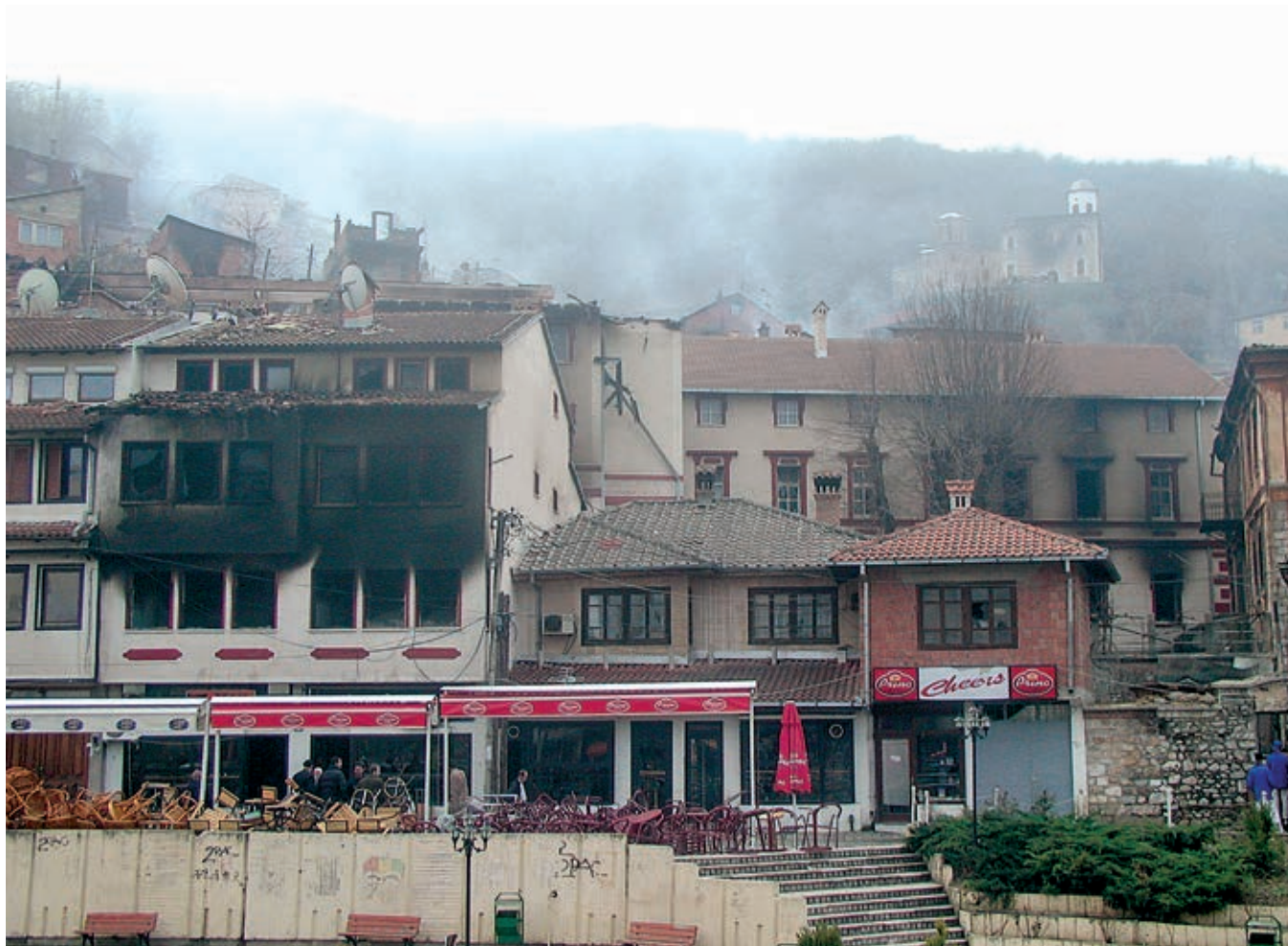
Сл. 360. Призрен, поглед на Поткаљају са обале Бистрице; на снимку се виде зграда Богословије и црква Светог Спаса у пламену у току Погрома, март 2004. године
