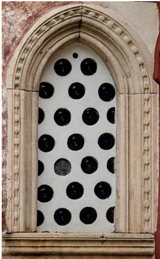
Сл. 172. Пећ, Богородичина црква, монофора на јужној фасади
