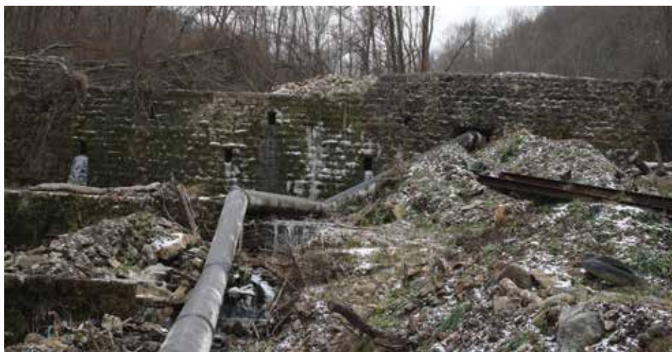
Слика 15. Уништен зуб слапишта на депонијско-консолидационој прегради број 2 на потоку Ракита (МХЕ „Звонце“) (Фото: Ратко Ристић)
