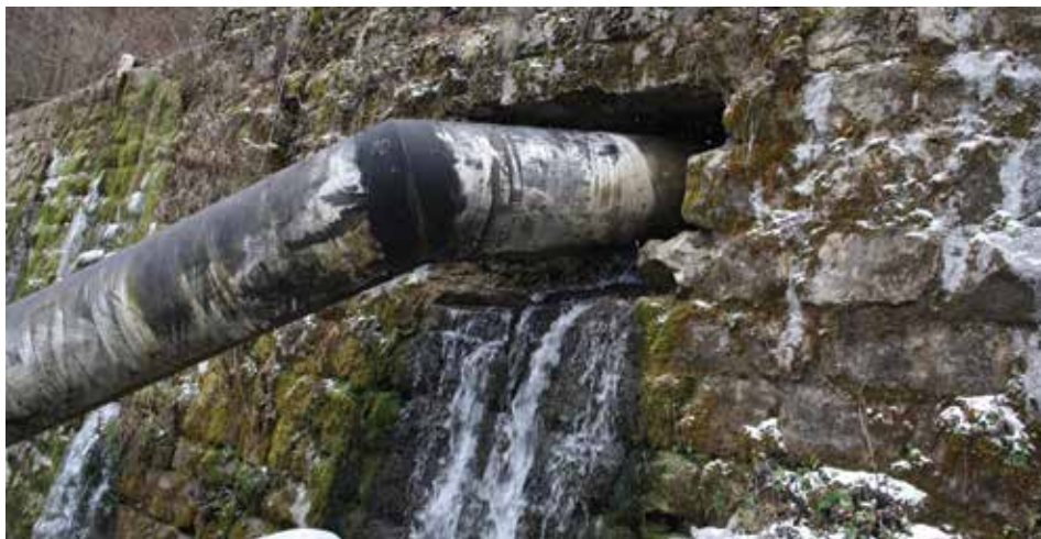
Слика 14. Пробијена депонијско-консолидациона преграда број 2 на потоку Ракита (МХЕ „Звонце“) (Фото: Ратко Ристић)
