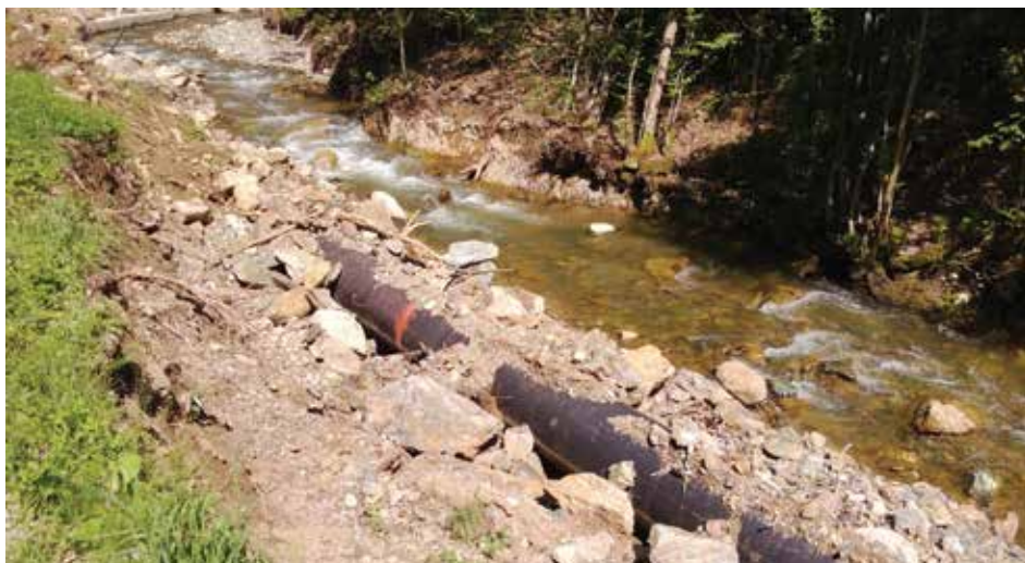
Слика 7. Полагање деривационог цевовода у кориту за велику воду (МХЕ „Мездреја“) (Фото: Ратко Ристић)
