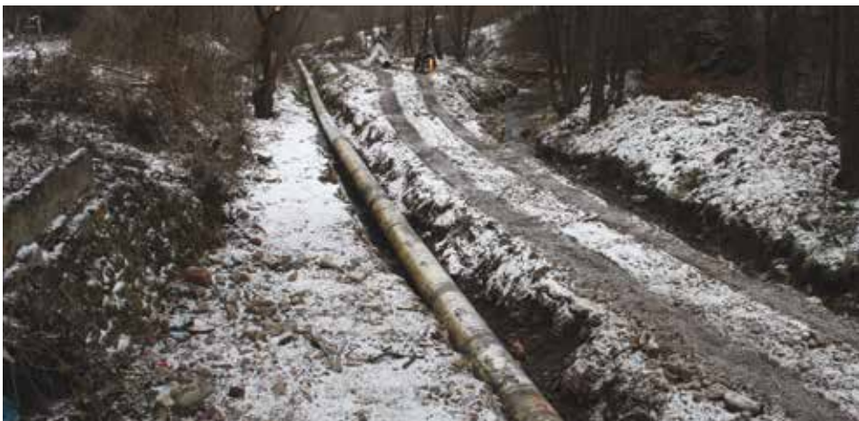
Слика 6. Полагање деривационог цеговода у кориту за велику воду (МХЕ „Звонце“) (Фото: Ратко Ристић)
