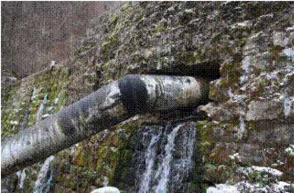
Слика 7. Кривично дело: пробијена бујична преграда на Ракити, изнад с. Звонце чиме је и конструкцијски и хидраулички дестабилована
