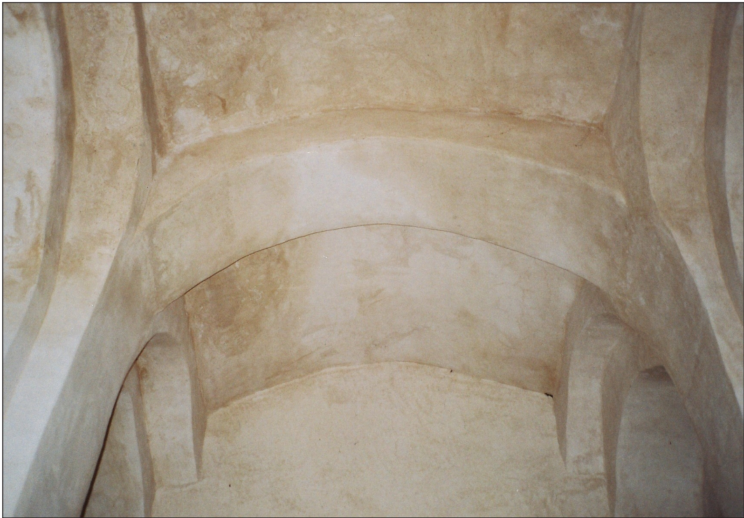
Таб. 13. Свод западног травеја цркве Св. Михаила
