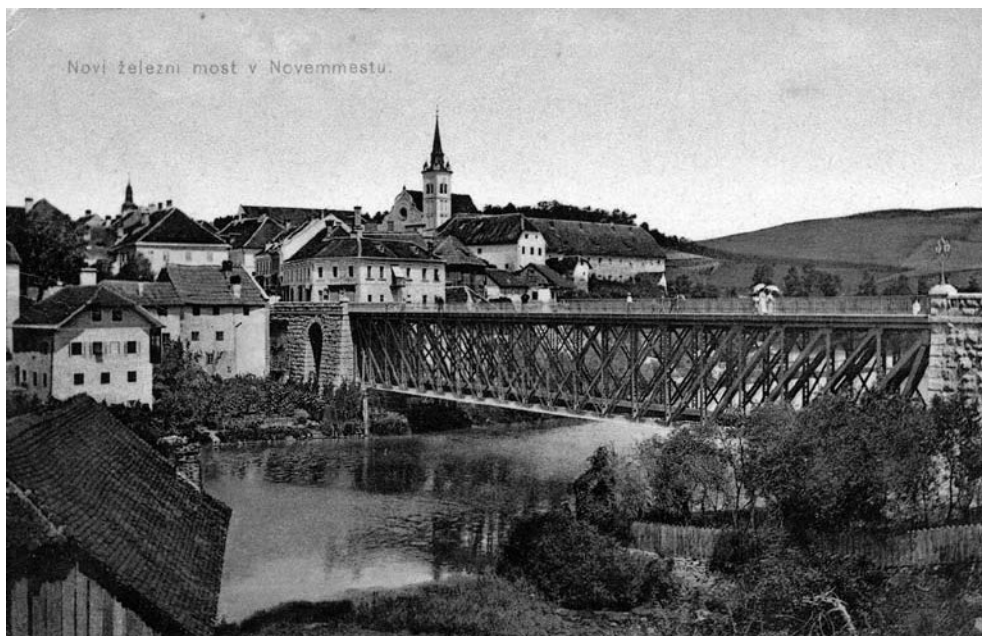
Železni most čez reko Krko, ki povezuje staro mestno jedro Novega mesta s Kandijo. Zgrajen je bil leta 1898 in sodi med najstarejše tovrstne konstrukcije na Slovenskem. (SI_ZAL_NME/0249 Zbirka razglednic, t. e. 1, a. e. 1)
