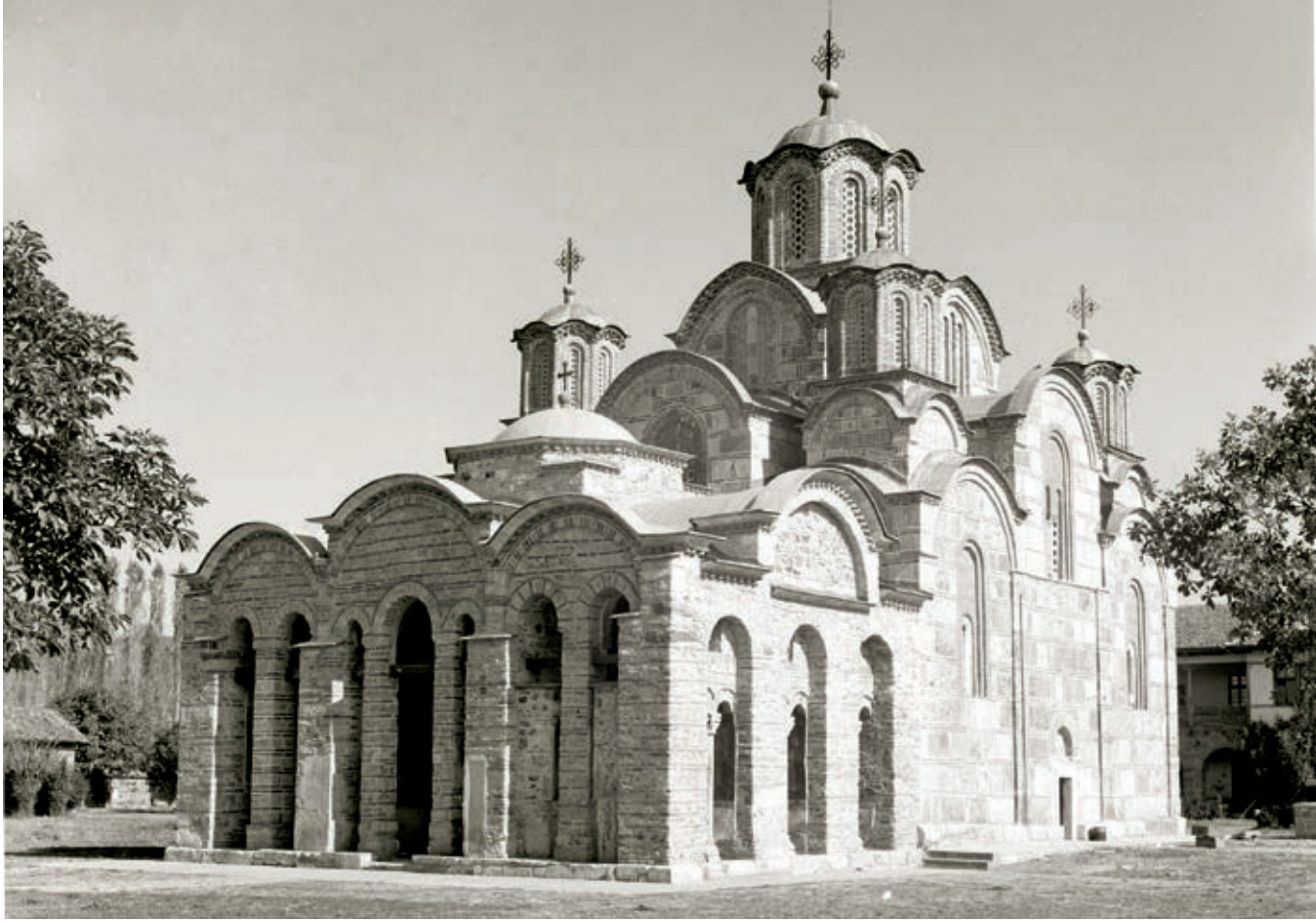
Сл. 397. Грачаница, спољна припрата после скидања малтера и отварања зазида, то јест враћања у претпостављено првобитно стање
