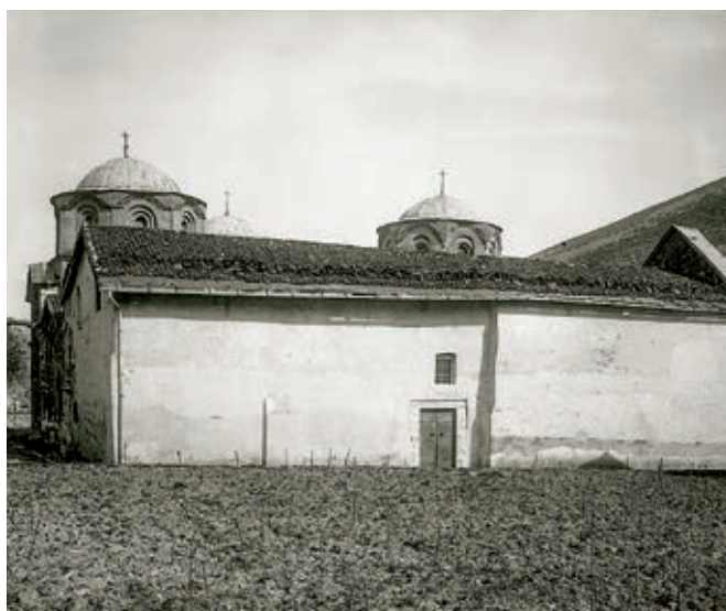
Сл. 377 и 378. Пешка патријаршија, јужна и западна фасада пре конзерваторско-рестаураторских радова из 1931–1932. године
