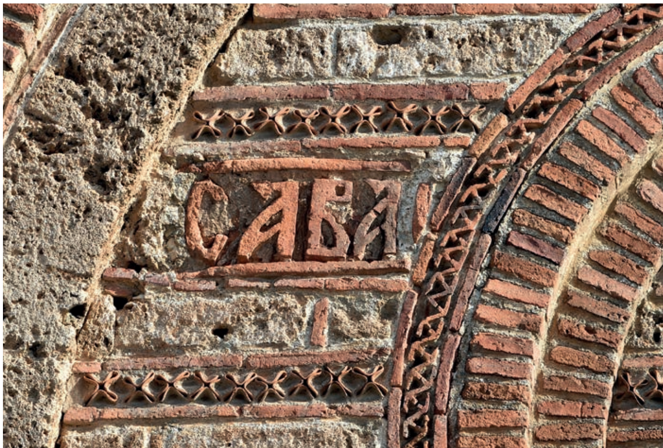
Сл. 119. Призрен, Богородица Љевиска, натпис на фасади са именом призренског епископа САВЕ
