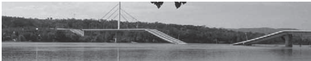
сл. 17 Друмски мост „Слобода“ преко Дунава у Новом Саду – после рушења
