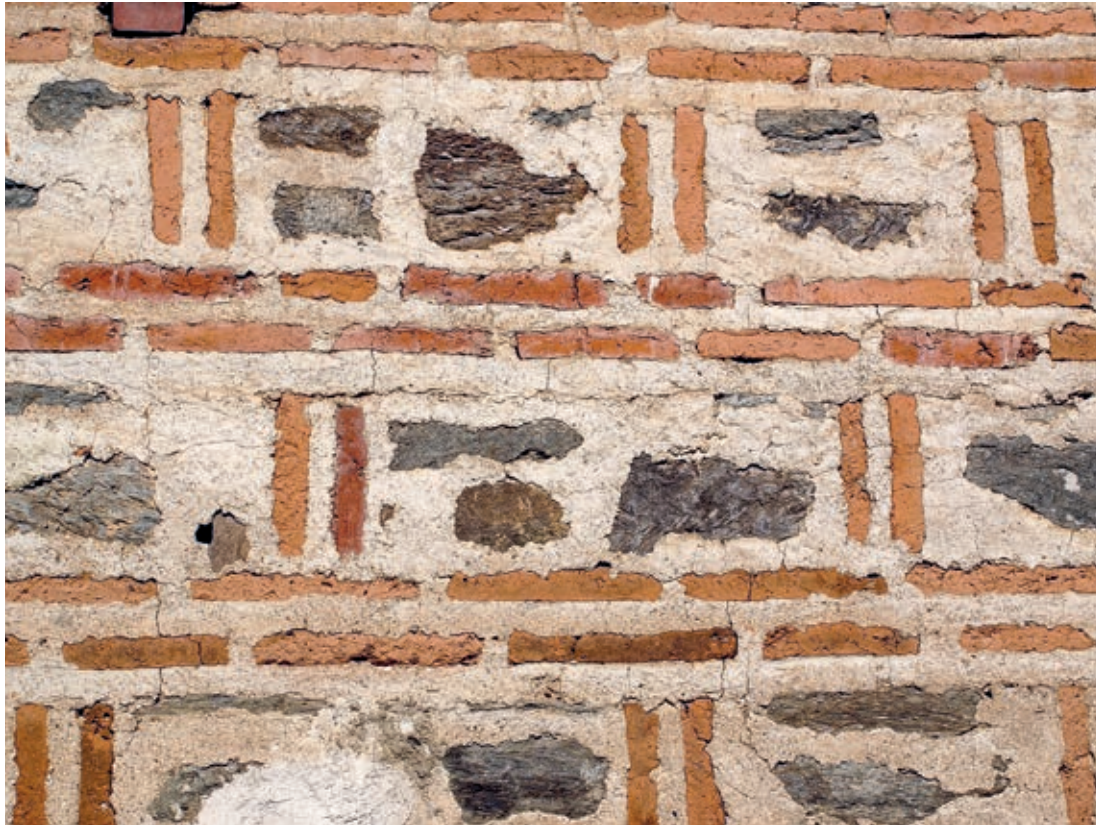
29. ГРАДИТЕЉСКИ СЛОГ СА ДВОСТРУКИМ НИЗОВИМА ОПЕКА И РЕДОВИМА КАМЕНИХ БЛОКОВА СА НАСАТИЦЕ УГРАЂЕНИМ ОПЕКАМА
