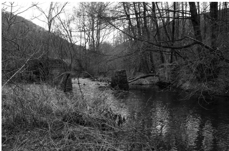
Сл. 6 – Остаци старог турског моста на Белици Fig. 6 – Remains of old Turkish bridge on Belica River.
