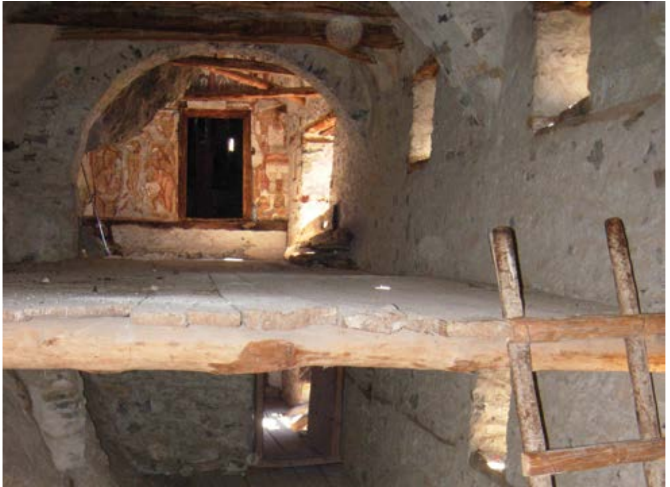
Εικ. 44 Το εσωτερικό του νέου κτηρίου από δυτικά. Το ξύλινο πάτωμα το χωρίζει σε δύο στάθμες. Στο βάθος, η πρόσοψη του ναού
