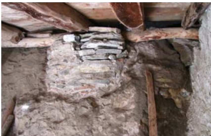
Εικ. 47 Κτιστός πεσσός στον πρώτο όροφο του νέου κτηρίου
