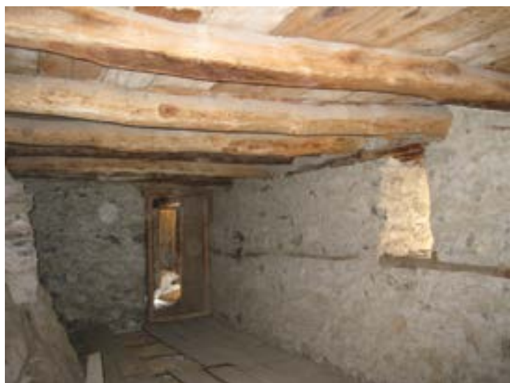
Εικ. 46 Εσωτερικό του πρώτου ορόφου του νέου κτηρίου από δυτικά. Στο βάθος η κύρια είσοδος
