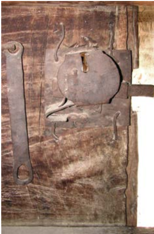
Εικ. 51 Η κλειδαριά της θύρας της δυτικής εισόδου του νέου κτηρίου
