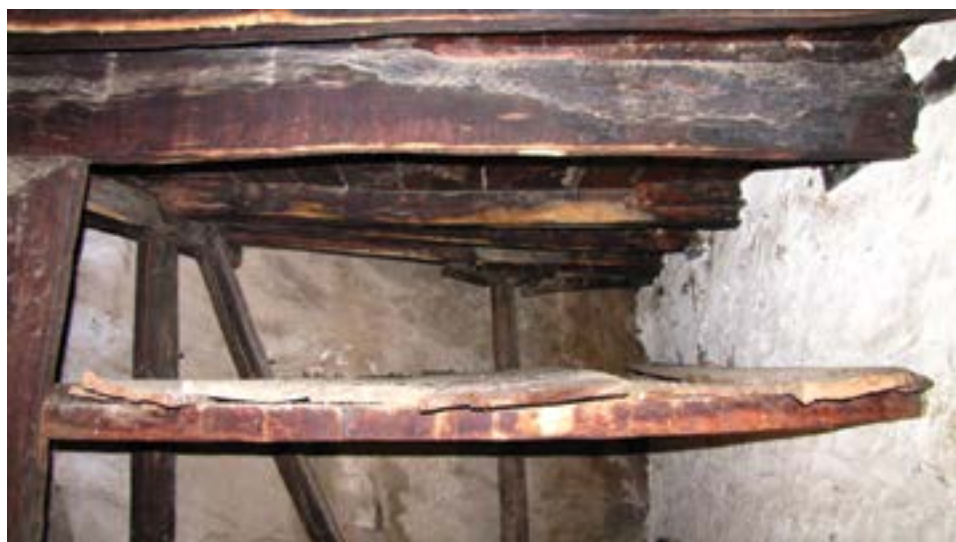
Εικ. 37 Κάτω όροφος. Οι δοκοί στήριξης του δαπέδου του ναού
