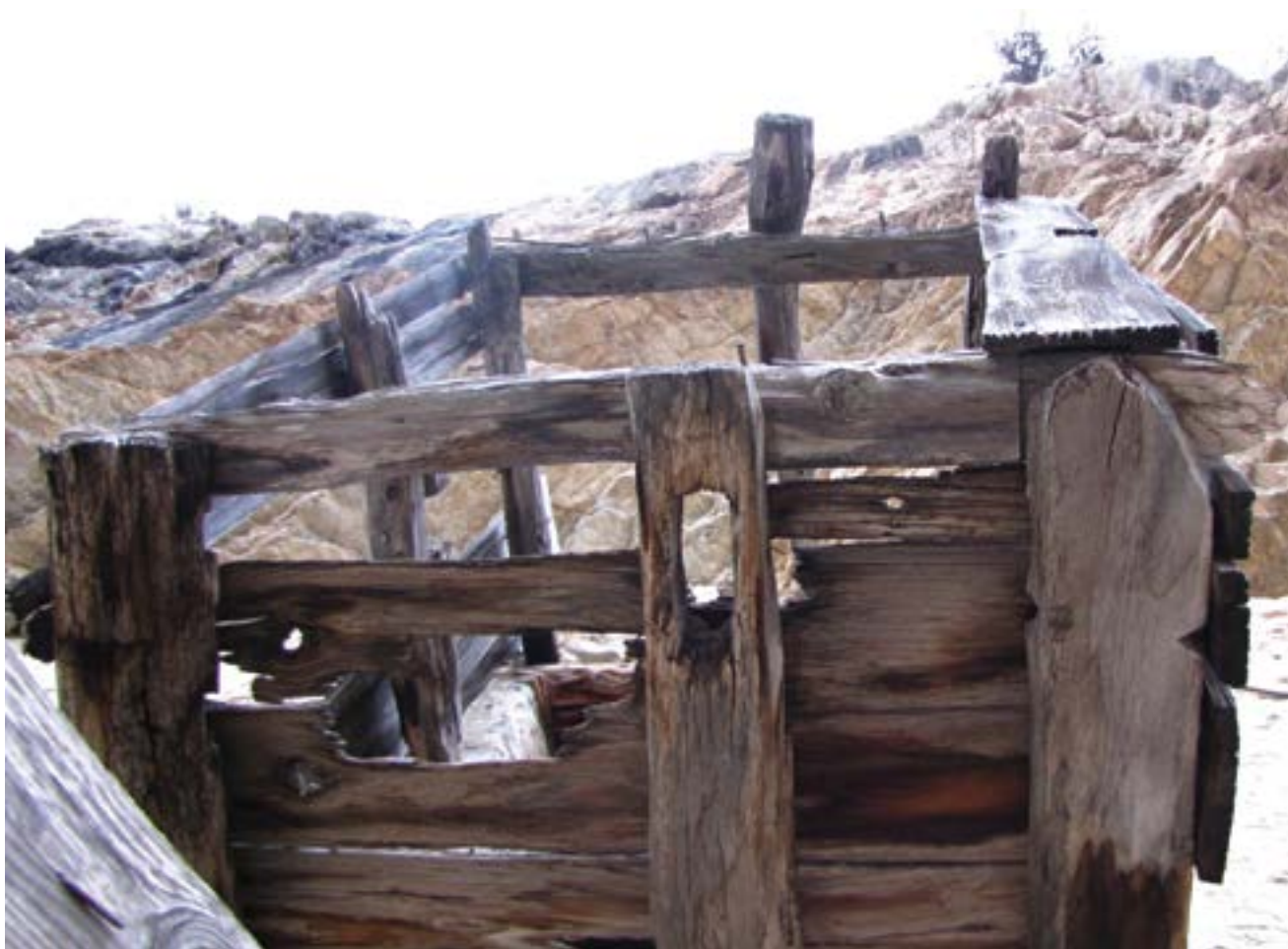
Εικ. 14 Οι κάτω πρόβολοι του εξώστη. Στο μεσαίο αρθρώνεται το καρούλι
