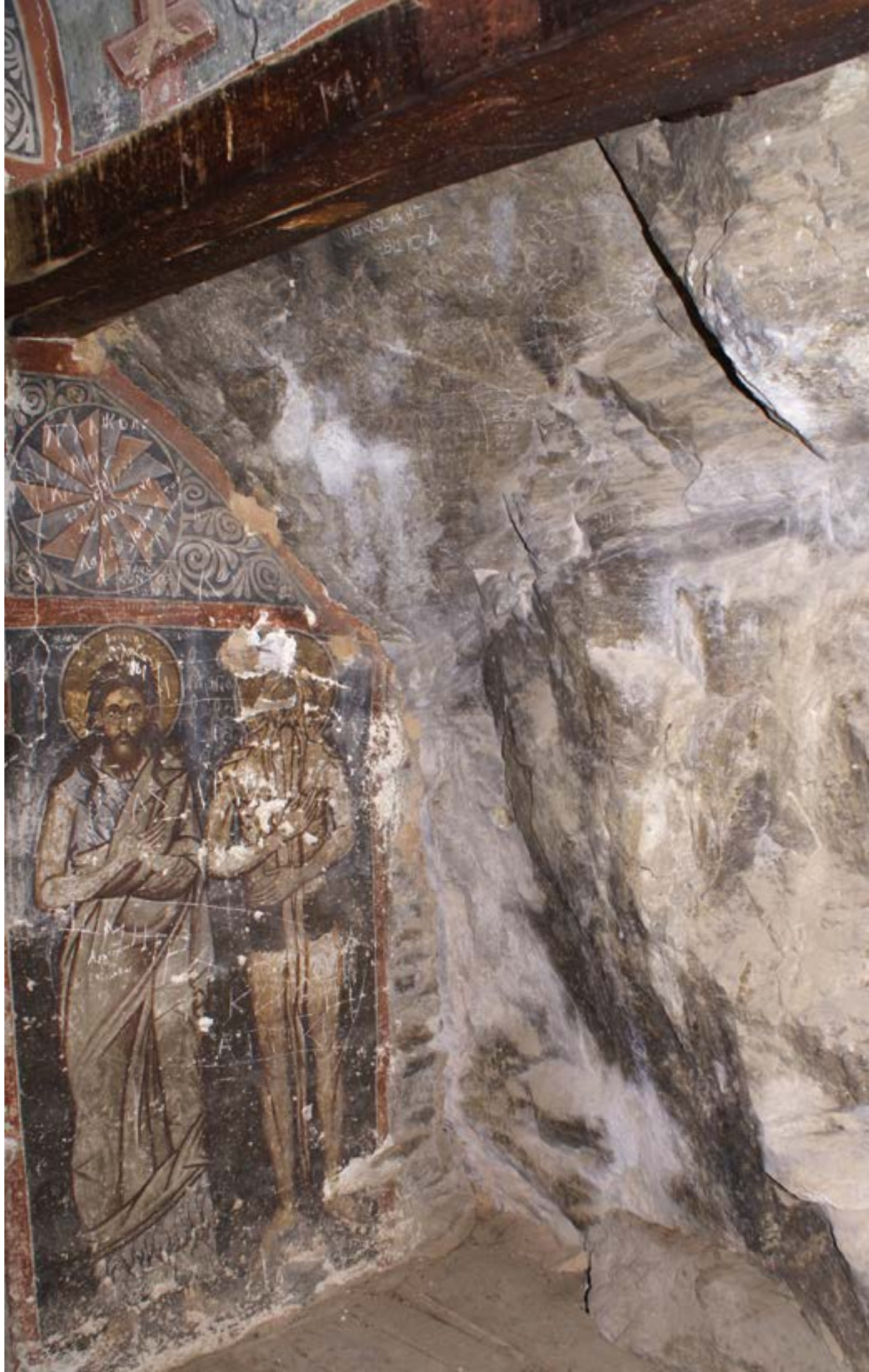
Εικ. 39 Ο βράχος της βόρειας πλευράς με την ξύλινη δοκό που στηρίζει την καμάρα του ναού
