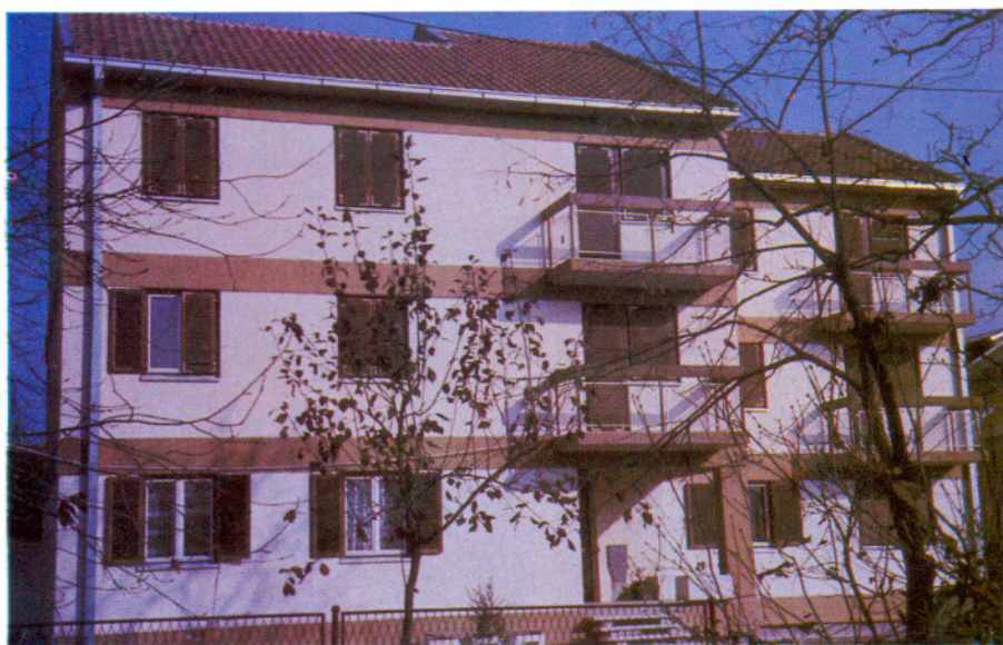
Završna obrada siporex-a
