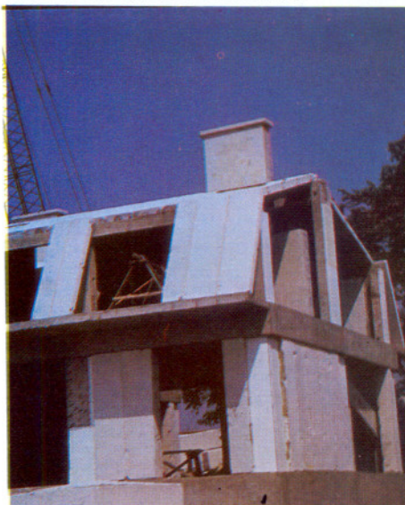
Omotač od siporex elemenata
