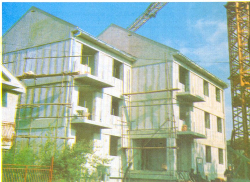
Omotač od siporex elemenata
