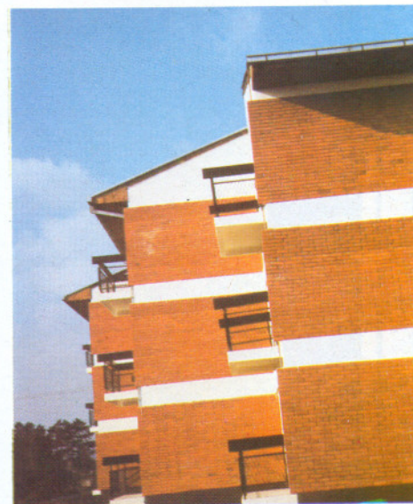
Detalj sendvič zida sa fasadnom opekom
