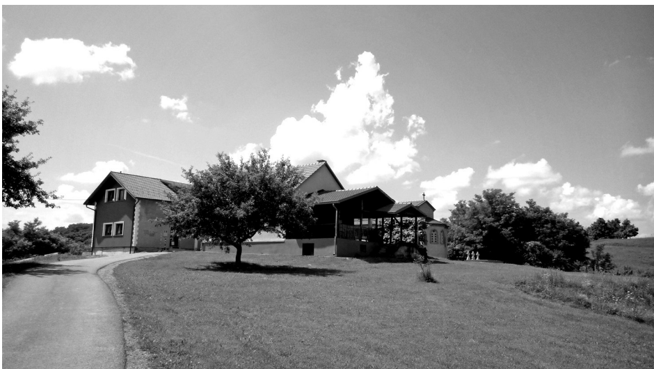
ОБНОВЉЕНИ ПАРОХИЈСКИ ДОМ И ИЗГРАДЊА МАНАСТИРСКОГ КОМПЛЕКСА
